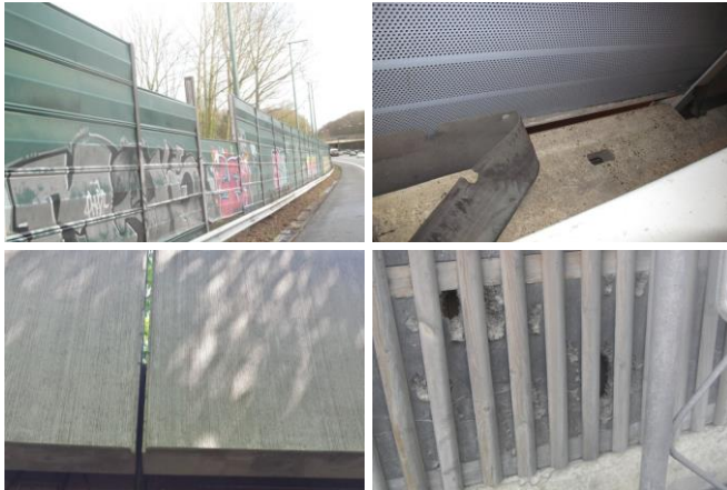
Abbildung 3: diverse Beschädigungen an Lsw; von links oben nach rechts unten: fehlende Aluminium-Lsw-Kassetten, schlitzförmige Leckage durch fehlende Bodenabschlussleiste, Schlitz durch fehlende Dichtung zwischen Beton-Lsw-Elementen, Löcher in Dämmmaterial an Holz-Lsw infolge von mechanischer Krafteinwirkung (Quellen: BMVI; Walloon Road Administration, Belgien)
